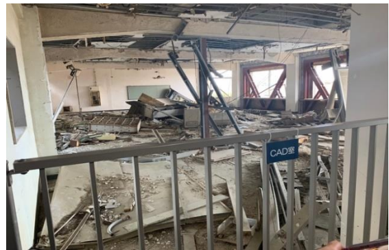
気仙沼市東日本大震災遺構・伝承館見学 津波被害をそのまま残した気仙沼向洋高校旧校舎内
