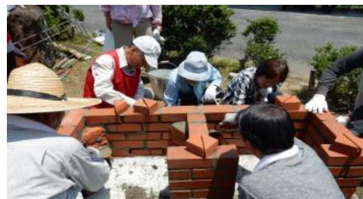
災害時に炊き出し可能な「かまどベンチ」作り
